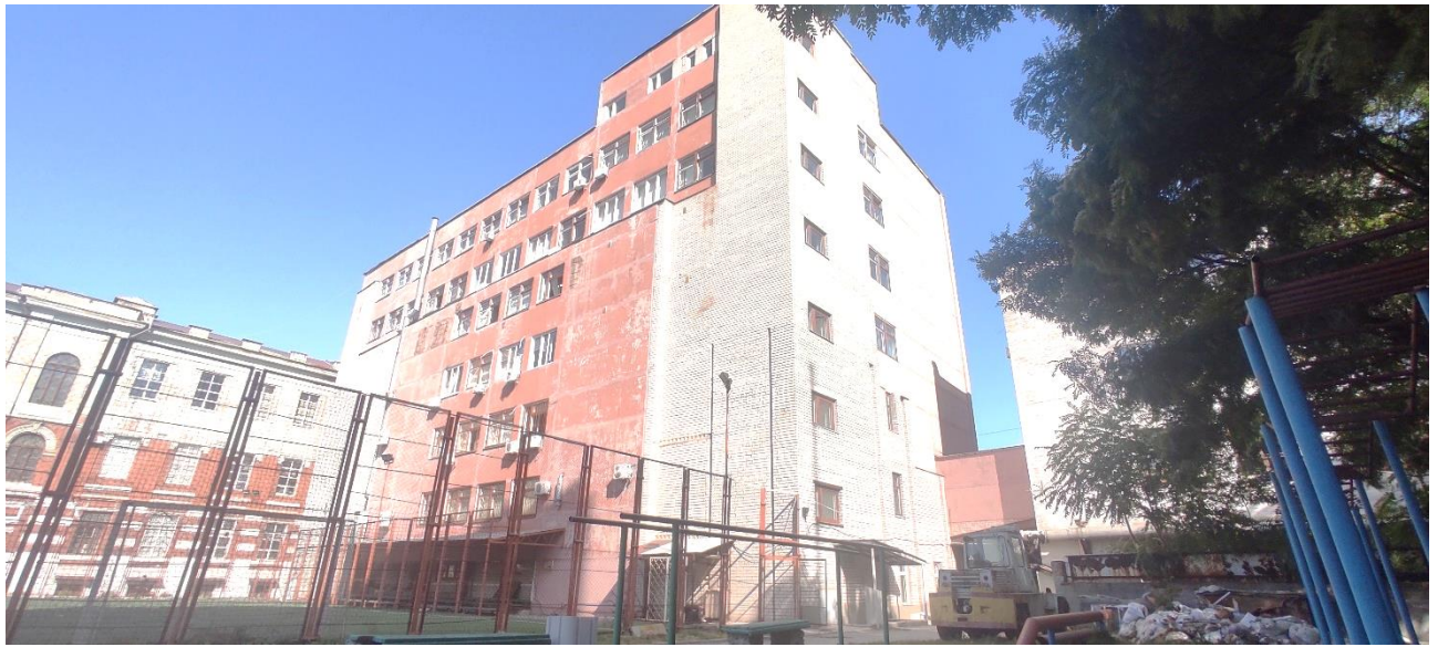
Фото 4 - Загальний вигляд фасаду об'єкта
