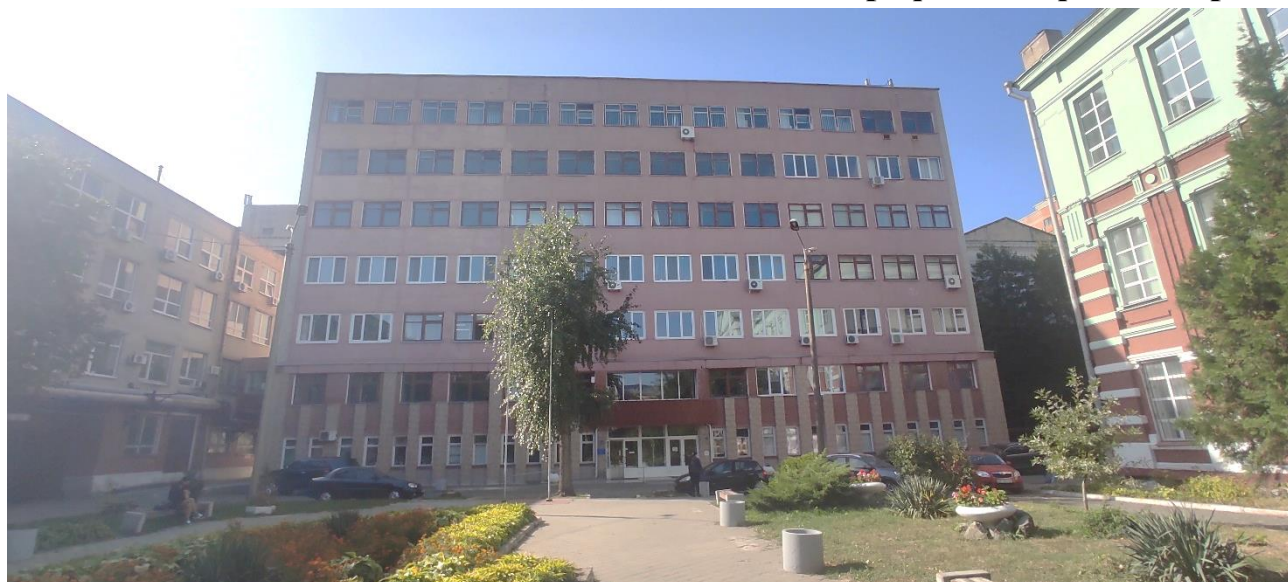
Фото 1 - Головний фасад – зі сторони просп. Д. Яворницького (центральна вхідна група із зовнішнім пандусом)
