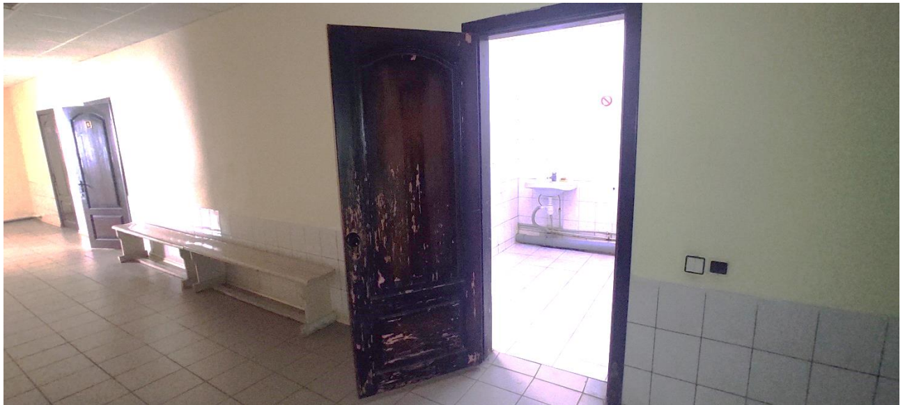
Фото 51 - Блок з санітарно-гігієнічними приміщеннями на першому поверсі
